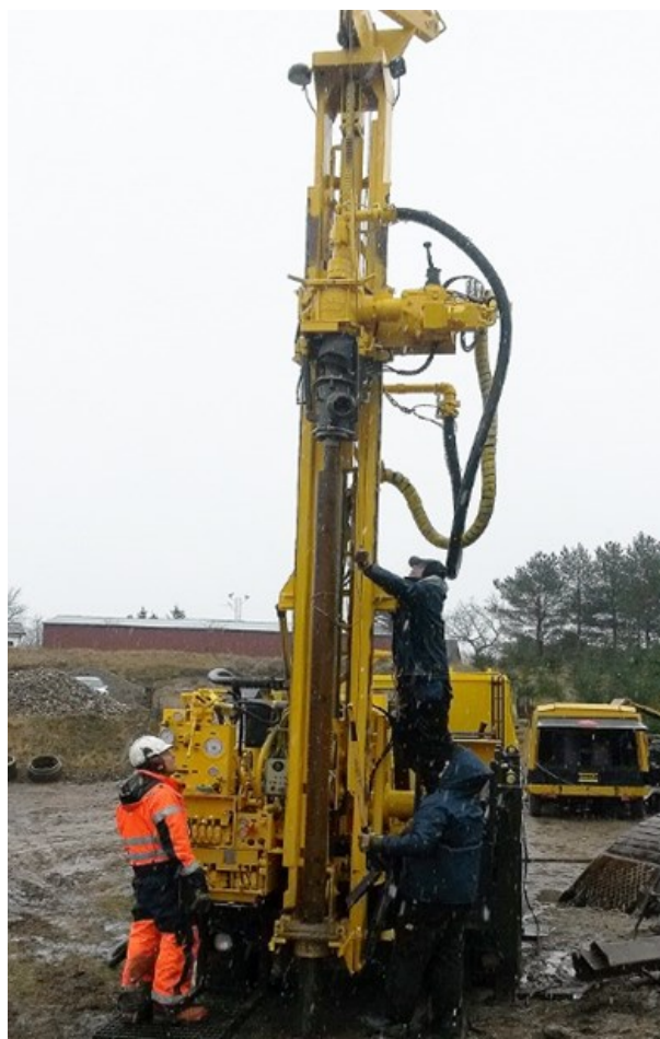
Figur 5. Hammarborrning med foderrör i Blentarps grustag, 31/3 2015.
