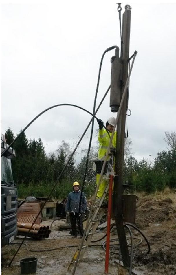
Figur 4. Rördrivning med 2'' rör i Blentarps grustag, 30/3 2015.
